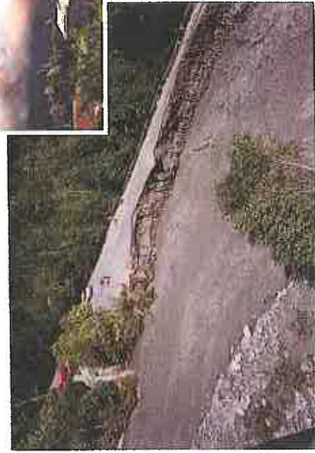
Incendie à Forcalquier en 1988. Source : DRM 04, Juillet 2005
