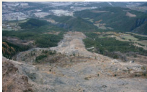
Mouvement de terrain de la Valette - Commune de Saint-Pons © Service Restauration des terrains de montagne (RTM) des Alpes-de-Haute-Provence
