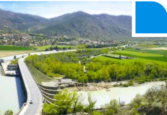
Barrage EDF de l'Escale
