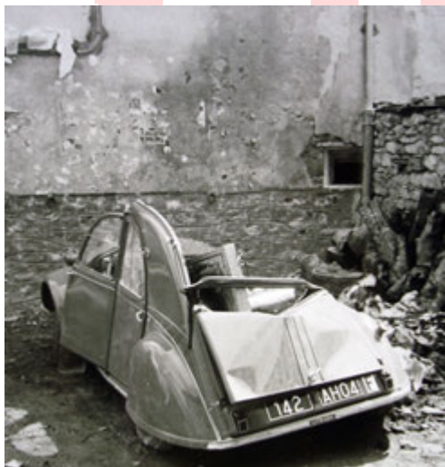
Dégâts suite au séisme de 1959 - Commune de Saint-Paul-sur-Ubaye © Nice Matin
