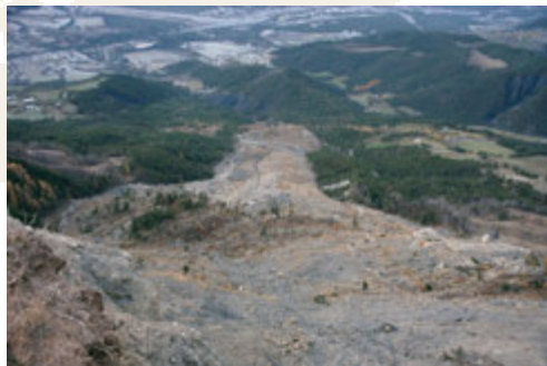
Mouvement de terrain de la Valette - Commune de Saint-Pons © Service Restauration des terrains de montagne (RTM) des Alpes-de-Haute-Provence
