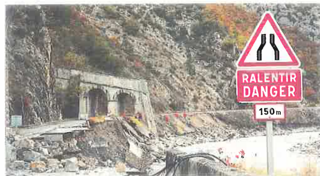
Dégâts suite à la crue du Var en 1994
