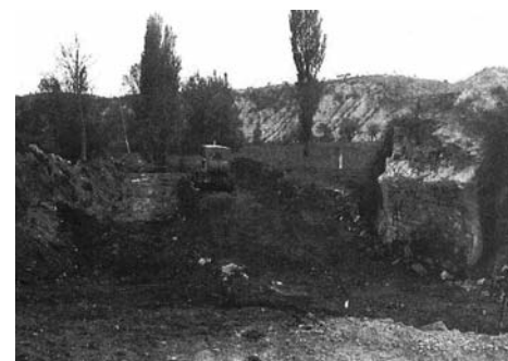
L'ancien pont de Sigonce emporté dans la nuit du 6 octobre 1960.
