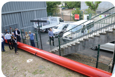
Digue mobile contre le risque d'inondation
