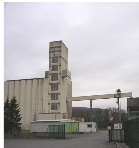
Le silo à grains
