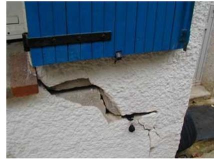
Cela peut provoquer des dégâts très importants sur les constructions (fissures, déformations des ouvertures) pouvant rendre inhabitables certains locaux.
