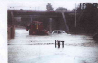
Inondations du 13 novembre 1999 Source : Mairie
