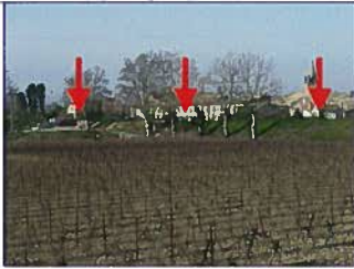
Digue de protection, station de pompage et portail des Crouzettes
