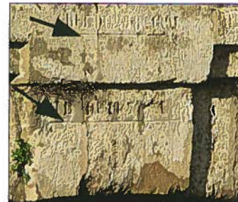
Crues des 25 8 BBE 1891 et 18 8 BBE 1843 gravées sur la voûte du pont sur le Canal de Jonction
