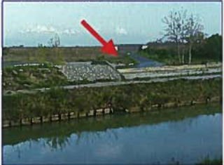
Déversoir le long du Canal
