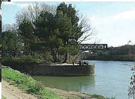
la confluence de l'Aude du Canal de jonction
