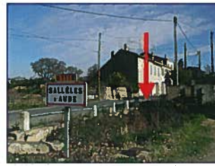
Route de Saint-Marcel fermée lors des crues par une porte métallique
