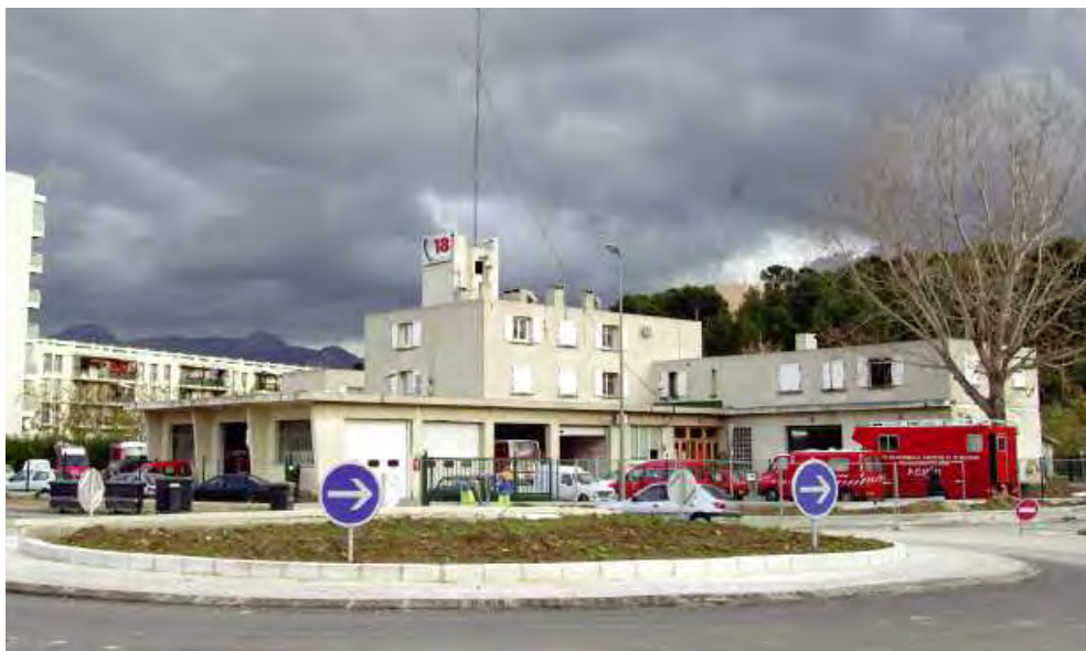
Centre de secours d'Aubagne
