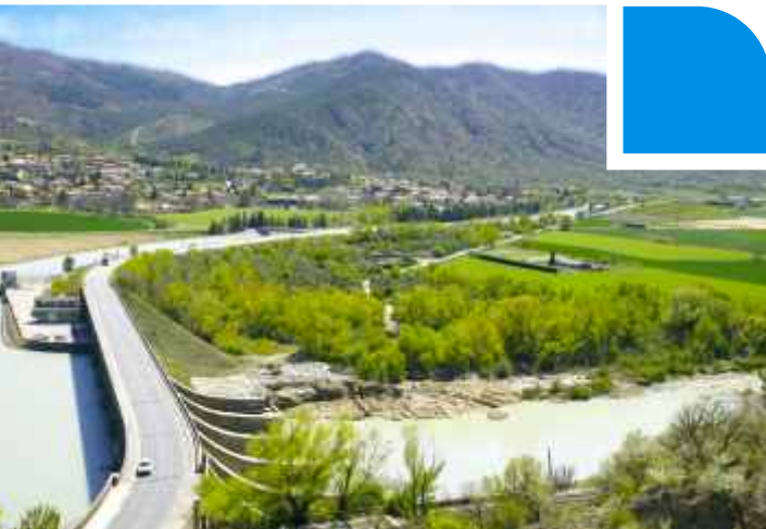
Barrage EDF de l'Escale
