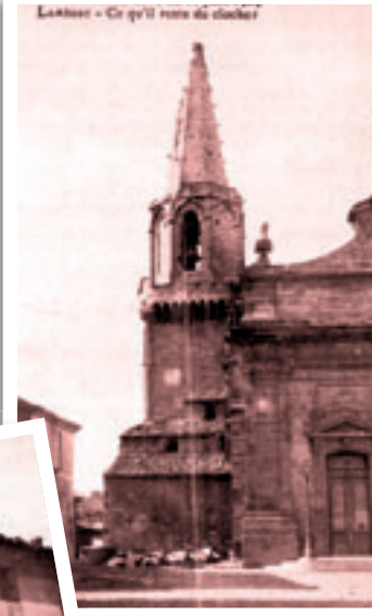
Séisme du 11/06/1909 Lambesc
