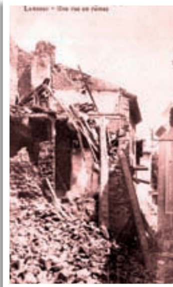
Séisme du 11/06/1909 Lambesc
