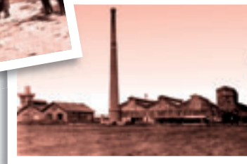
Usine de Dynamite Saint Martin de Crau
