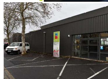
Gymnase des Camisières ©Christian GENOT
