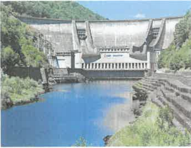
Barrage de Chastang (19) - © Thierry DEGEN - DREAL Nouvelle-Aquitaine
