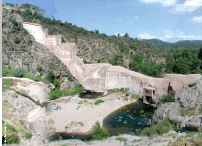
Ruines du barrage de Malpasset
