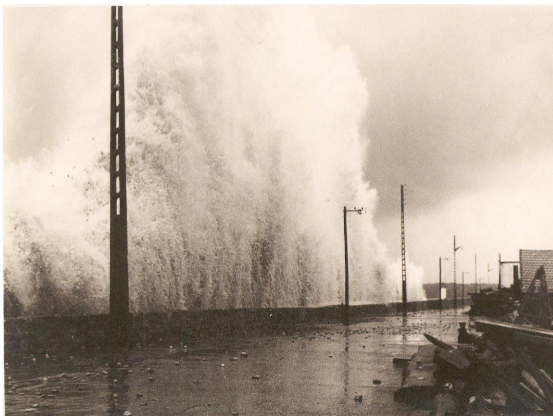
Illustration d'un phénomène de vagues ayant submergé le Sillon dans les années 60, Depuis les travaux d'enrochement, Camaret ne connaît plus de tels assauts de la mer.
