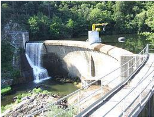
Barrage des Cambous sur le Gardon d'Alès
