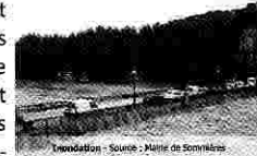
Inondation - Source : Mairie de Sommières
