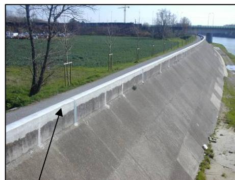
Relèvement du parapet depuis le Pont de Blagnac (réhaussement de 20 cm réalisé entre 1998 et 1999)
