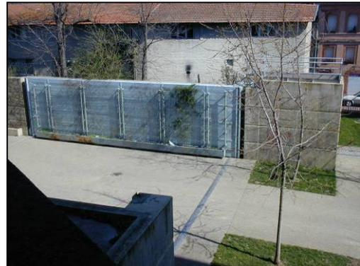
La porte de la Garonnette ouverte (travaux réalisés entre 1997 et 1999). Auparavant, le seul dispositif possible pour endiguer les crues était la mise en place d'un batardeau constitué de sacs de sable.
