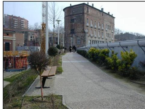
Les mesures de protection au niveau du Bazacle ont été le remplacement du mur par une digue plus haute et plus résistante (en béton armé). Cette nouvelle digue a été accompagnée à l'arrière d'un talus en terre avec promenade et aménagement paysager (hauteur totale de 10,80 m, travaux terminés en 2002).
