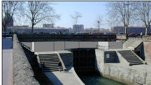
Photomontage de l'écluse avec les batardeaux en place (SETN). Les travaux ont été réalisés en 2001.
