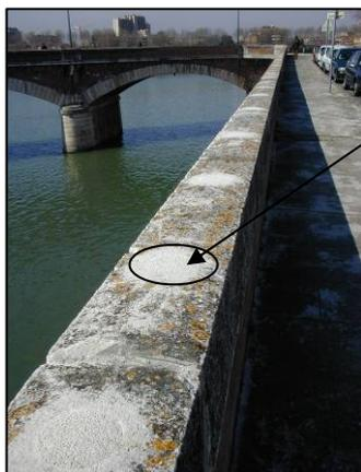
Détail de l'emplacement des micropieux sur le parapet de l'avenue M. Hauriou (travaux réalisés entre 1998 et 1999)
