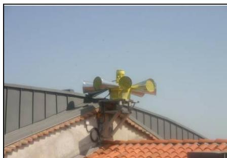
Dans le cas particulier des ruptures de barrage, le signal d'alerte est émis par des sirènes pneumatiques de type " corne de brume ", installées en aval immédiat par l'exploitant du barrage. Il comporte un cycle d'une durée minimum de deux minutes, composé d'émissions sonores de deux secondes séparées par un intervalle de trois secondes.
