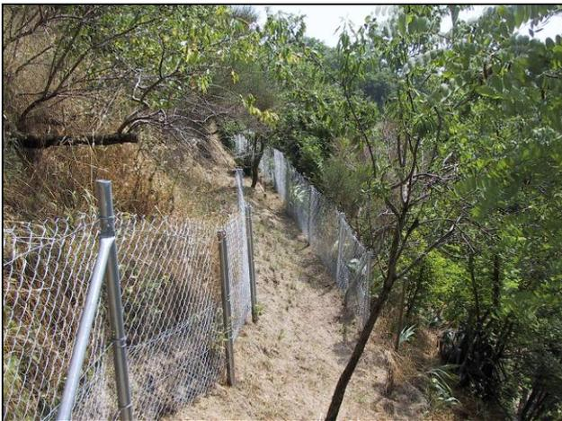
Ces ouvrages sont fiables vis-à-vis des instabilités courantes, mais ne permettent de garantir qu'un laps de temps suffisant pour l'évacuation des personnes vis-à-vis de grands glissements.
