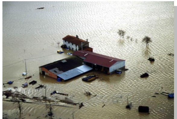
Inondation après la tempête de 1999 (DDE 33)
