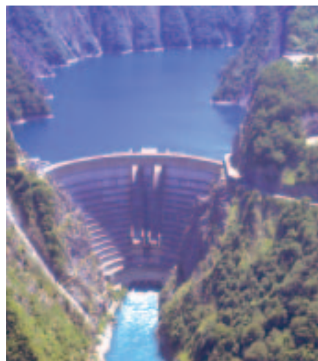
Le barrage de Monteynard, un des six grands barrages de la région
