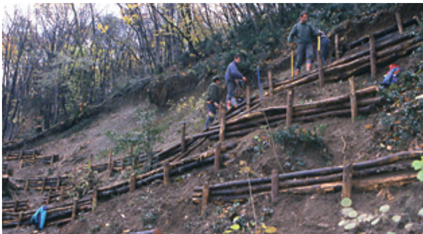
Mouvement de terrain : les paliers de stabilisation du terrain installés à la Frange verte par L'ONF.
