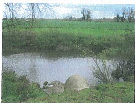
Sortie station d'épuration en temps normal
