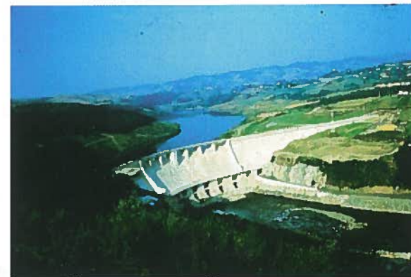
BARRAGE DE VILLEREST (Source DIREN)
