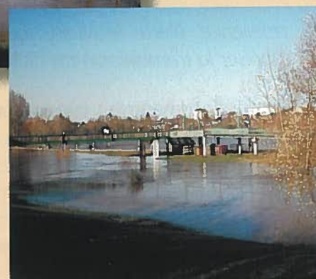
Echelle à proximité du Pont SNCF
