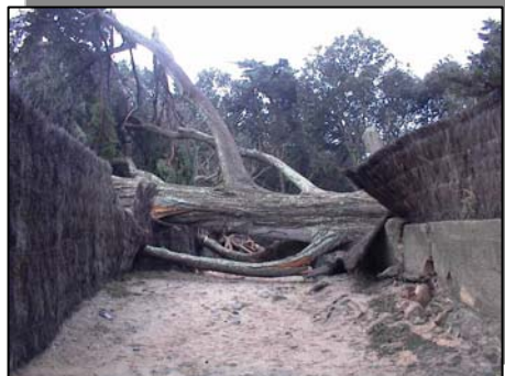
Lors de la tempête du 26 décembre 1999, les rafales de vent ont atteint la vitesse de 151 km/h, occasionnant des dégâts considérables
