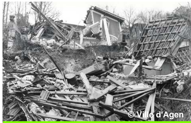
Janvier 1961 : maison détruite
