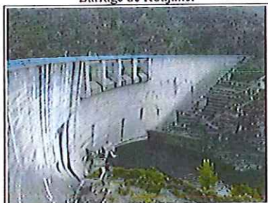
Barrage de Roujanel
