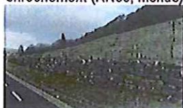
Exemple de confortement par enrochement (RN88, Mende)
