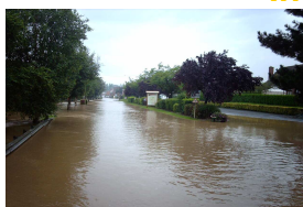
Débordements de la Grande Becque
