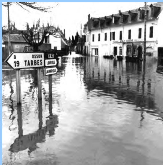
Inondation de février 1978 - Place Estibayres
