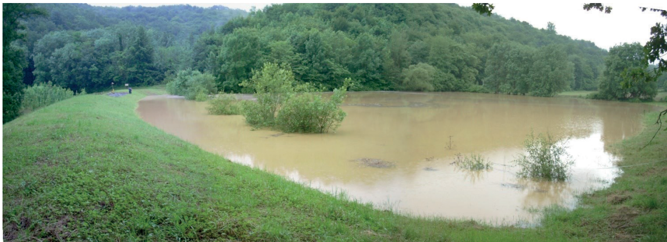
Ouvrage de la Maison-Commune en charge le 11 juin 2008
