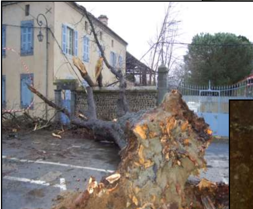
Dégradation des réseaux (Electricité, téléphone)
