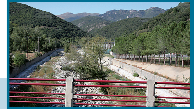
Pont RD 115 sur le Riuferrier
