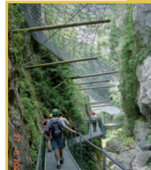
Les gorges de la Fou, filets de protection © service RTM
