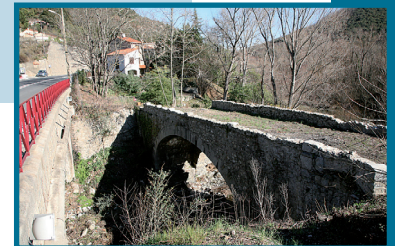
Le Bonabosc sous le pont RD 115
