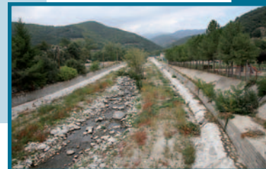
Le Riuferrer pendant et après travaux
