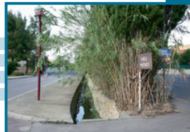
Canal de drainage
