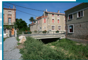
La Riberette – pont av. Jean Jaurès (D612)
