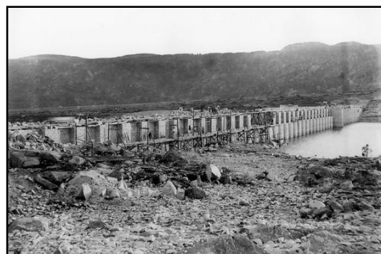
Photo de la construction du barrage des Bouillouses, mis en service en 1910 pour fournir l'électricité au train Cerdan
