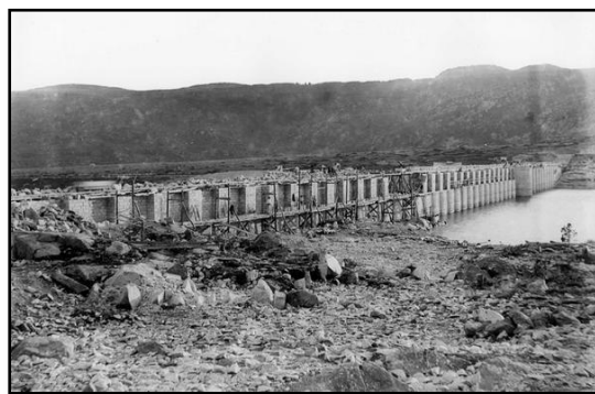
Photo de la construction du barrage des Bouillouses, mis en service en 1910 pour fournir l'électricité au train Cerdan.
