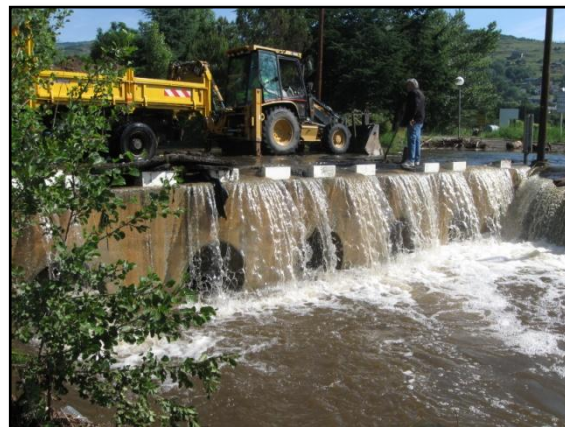
Comblement de l'Estagouge, en amont du pont de la route menant à Llivia lors de la crue de Juillet 2010.
