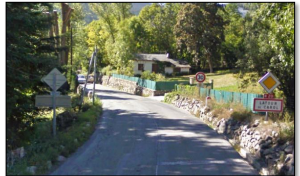
Route Nationale 20 qui traverse la commune de Latour-de-Carol. (Source : Google earth)
