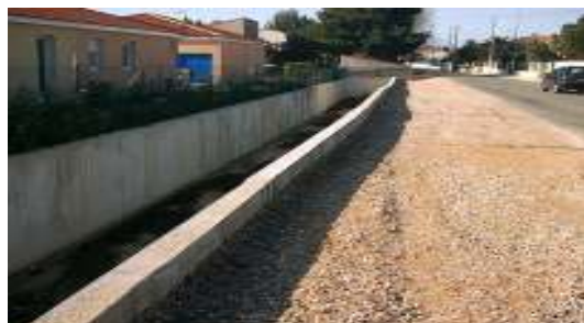
L'OUVRAGE TV4, AVENUE GUYNEMER
