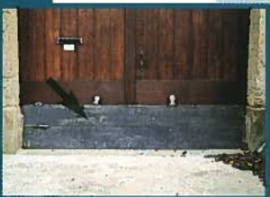
une «tampe» mise en place
