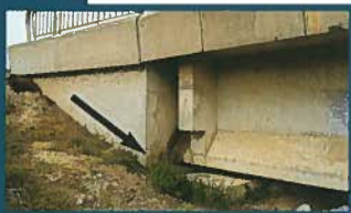
repère de la crue de 1999 sur la culée du pont RD 11
