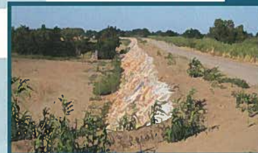
enrochements des berges de l'Agly
