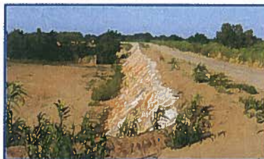
Enrochement des berges de l'Agly
