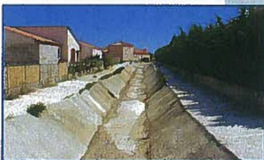
Cuvelage du Canal de l'Aveurade
