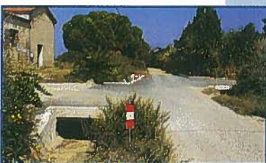
Ouvrage cadre Mas Pagnon
