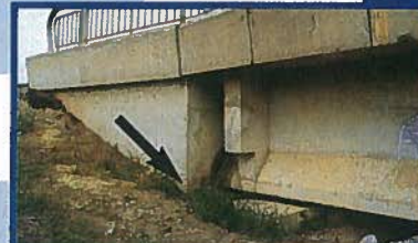
Repère de la crue de 1999 sur la culée du Pont RD 11
