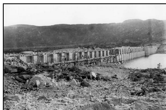
Photo de la construction du barrage des Bouillouses, mis en service en 1910 pour fournir l'électricité au train Cerdans
