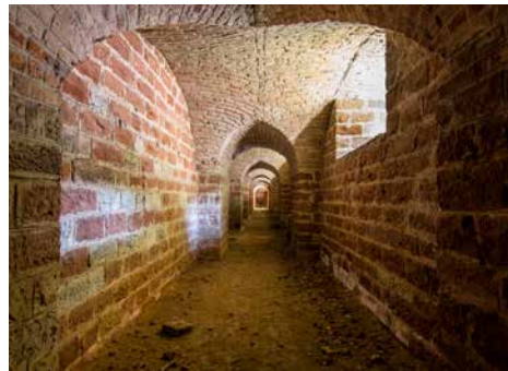
> Exemple d'un ouvrage militaire souterrain
