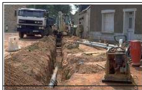
Exemple d'installations de canalisations souterraines de gaz
