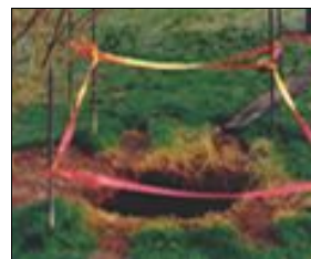
Mouvement de terrain (cavités souterraines)
