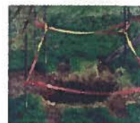
Mouvement de terrain (cavités souterraines)
