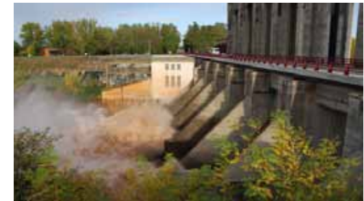
Barrage de Rivière
