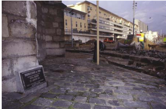
Place du marché : repère historique de la crue de 1910.
